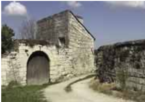
Portail d'entrée et maison couverte « en appentis » à l'est du hameau (XVIII e siècle).
