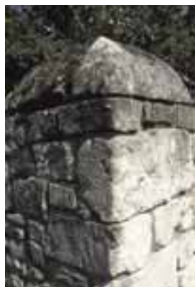
Traitement supérieur du mur appelé aussi « chaperonnage ».
