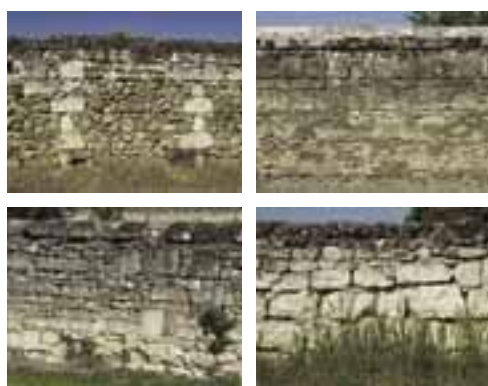
Diversité de la mise en œuvre des matériaux dans la construction des clos.
