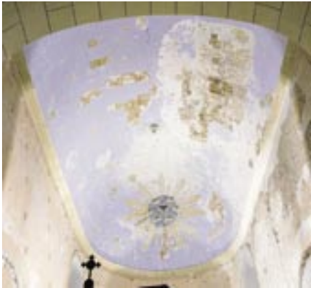
Vue des sondages.
