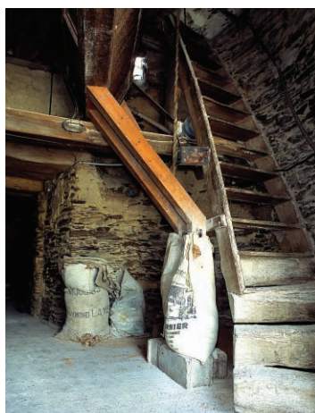
Au rez-de-chaussée, ensachage et escalier.
