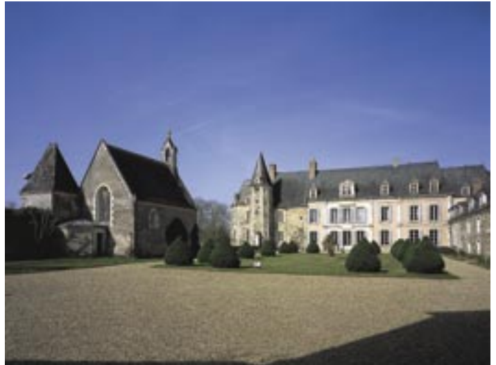
Logis et chapelle autour d'une grande cour autrefois divisée en avant-cour et cour d'honneur.
