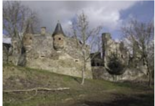
Vue du boulevard d'artillerie depuis le sud-est.
