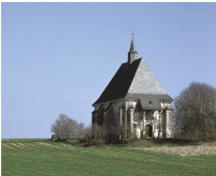
Chapelle de Montplacé, ensemble depuis le nord.
