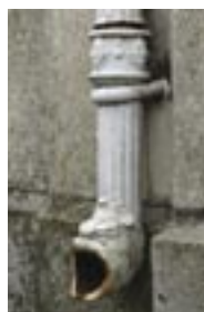
Le « dauphin », extrémité inférieure du tuyau de descente des eaux.
