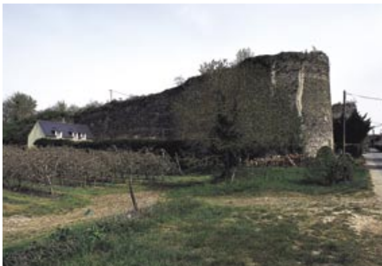
L'usine de chaux du Petit-Lapin comprend deux fours construits en 1840 et 1845. La rampe de chargement du four sud est conservée.
