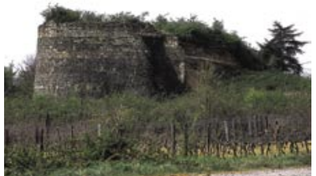
Le four de Montpellier, ou de Grand-Lièvre, a été construit à la fin du XVIII e siècle ou au début du suivant. À droite, on aperçoit les vestiges de sa rampe qui permettait de charger le charbon et la pierre par le haut du four.
