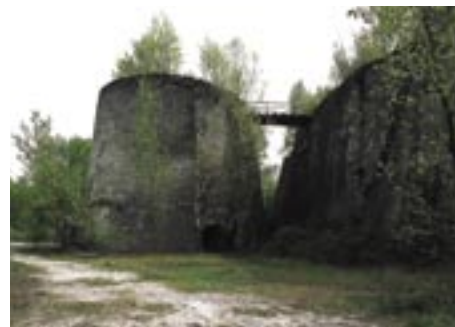
Le site de Chateaupanne, exploité depuis le XVIII e siècle jusqu'au cours de la seconde moitié du XX e siècle. Ici, le four de l'Union, en avant du massif enfermant les fours de Clermont et Jalousie.
