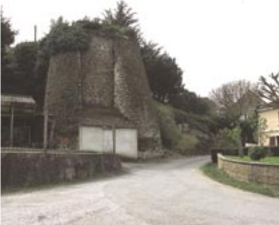
Le four du Lion, construit au XVIII e siècle, est un petit four traditionnel appuyé au coteau. Il comptait trois ébraisoirs et sa tour est renforcée par deux gros contreforts.
