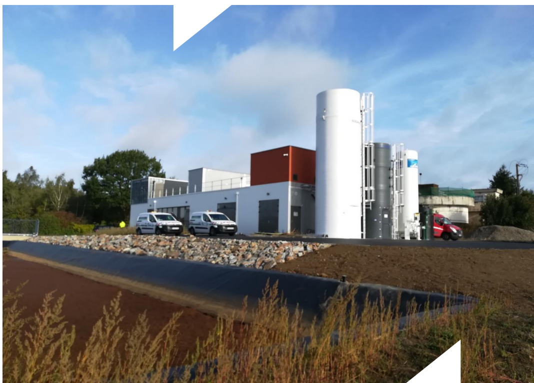
Photo : Nouvelle usine d'eau potable de Chazé-Henry – Septembre 2019
